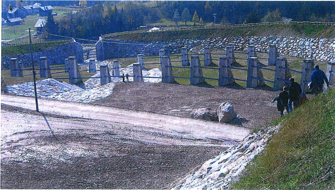
Fig. 11. Esempio di piazza di deposito con sistema frangicolata realizzato in Val d'Aosta
