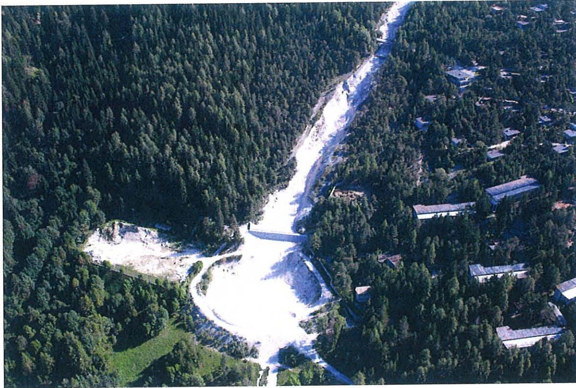
Fig. 6. Vasca di ritenuta del materiale a monte dell'abitato di Cancia.
